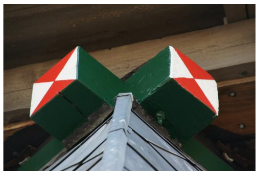
Het boventafelement (een deel van de onderzetel) van de Nieuw Leven , Hazerswoude-Dorp
