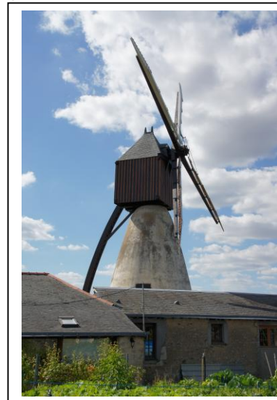
De Moulin de la Montagne in Thouarcé, een moulin cavier Gevlucht: systeem-Berton
